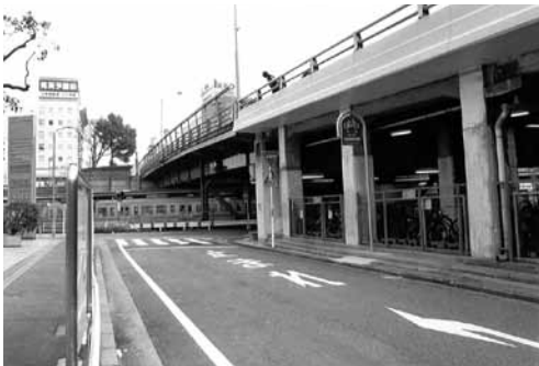
JRの千種駅。上を錦通が、下を地下鉄が通っている
