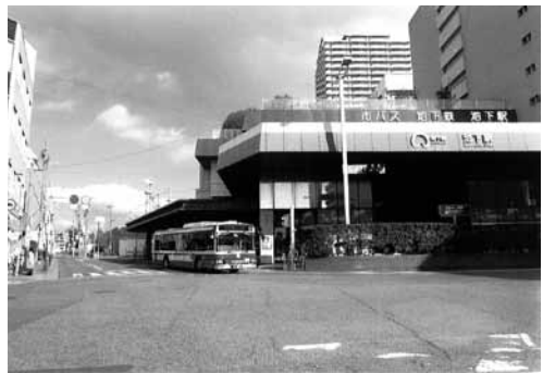
地上に出る池下駅。バスターミナルと併設される。 左の道を奥に進むと右側が地下車庫の跡になる
