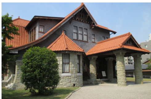
二葉館の正面。印象的な、複雑に組み合わせられたオレンジ色の屋根
