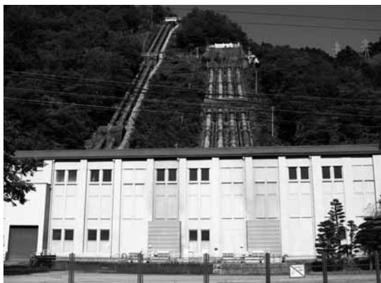
瀬戸発電所(右:旧第一発電所、左:旧第二発電所)
