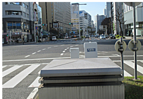
高速度鉄道が地下になってできた錦通。 道路中央に換気口が見える
