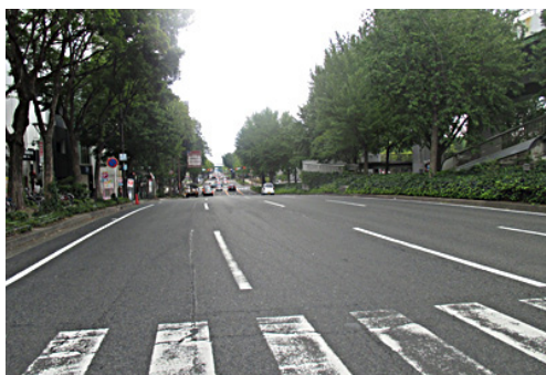
百米道路の東側は、坂で下っている。 大津通は台地の縁の通されたのがわかる
