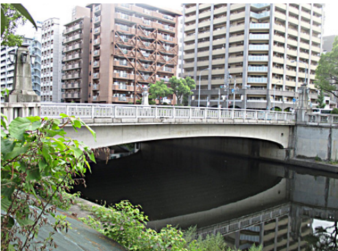
新堀川にかかる記念橋。背後はビル街に変わっている
