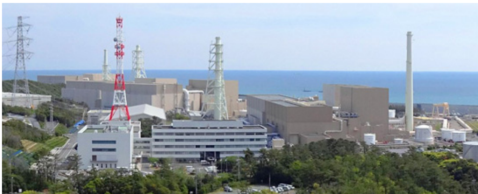
浜岡原子力発電所
