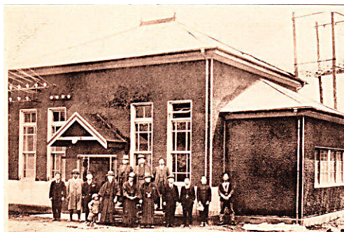
高遠変電所(当時)「電力絵葉書博物館」
