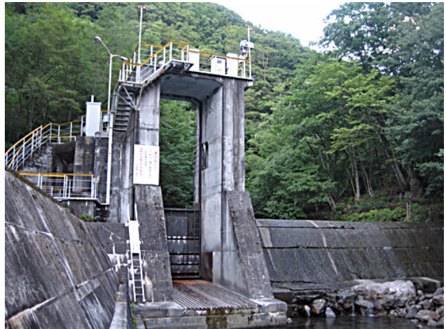
戸台発電所 堰堤現況
