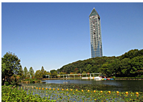
元の溜池(上池)が、公園の池として生かされた。 近年できたスカイタワーがそびえる
