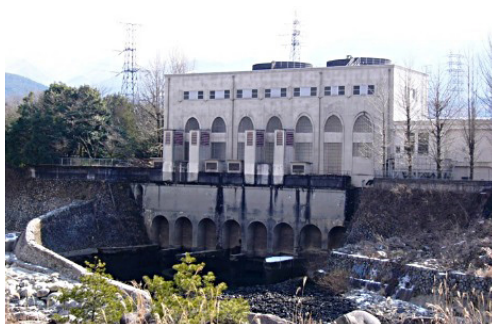
落合発電所全景
