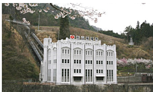
桃山発電所全景
