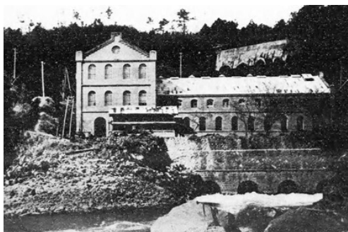
総発電力6,360kWの曾木第二発電所 右上：4本水圧鉄管水槽、有効落差約33m (出典：日本窒素事業概要、昭和15刊)
