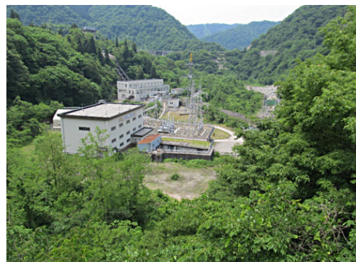
祖山発電所(奥)と新祖山発電所(手前)全景
