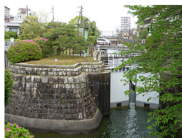
琵琶湖疏水の天津制水閘門
