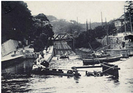
南禅寺舟溜の複線インクライン [左端中] 1912年2月建設の余水路放流口 [中央] インクライン、[右端中] 発電所の排水水路口 (出典：京都市営電気事業沿革誌 1934年刊)
