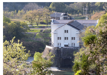
最大発電力14700kW賤母発電所 (左：第1期工事放水口、 中央：第2期工事放水口)
