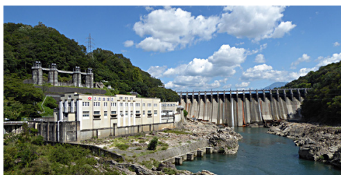
当時日本最大の大井ダムと大井発電所 [1922年7月着工、堤高53.3m、堤頂長257.7m、 最大使用水量:85.0m 3 /秒、有効落差:43.96m。 所在地:岐阜県恵那市大井町字奥戸]
