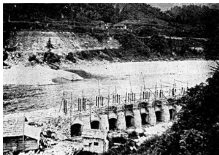
大桑発電所〔旧大桑第2水力〕の取水口工事風景 〔対岸で堰堤築造中、現：長野県大桑村殿928〕 (出典：大桑発電事業誌、1926年刊)
