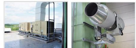
写真3: クールクリーンファン 写真4: 誘引SFファン
