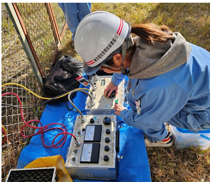
写真：年次点検における継電器の試験を行う様子。学校の現場なので真冬の年末。
