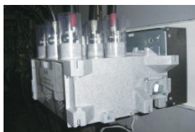
取替後のVCB
