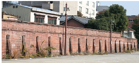
最近まで残っていた旧名古屋電気鉄道発電所跡の煉瓦壁
