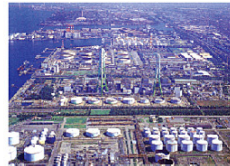
知多火力発電所現況
