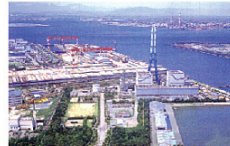
知多第二火力発電所現況
