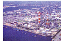
名古屋第二火力発電所現況
