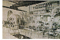
発電所内部(蒸気タービン発電機)
