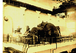
名古屋火力発電所のタービン・発電機
