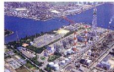
四日市火力発電所現況
